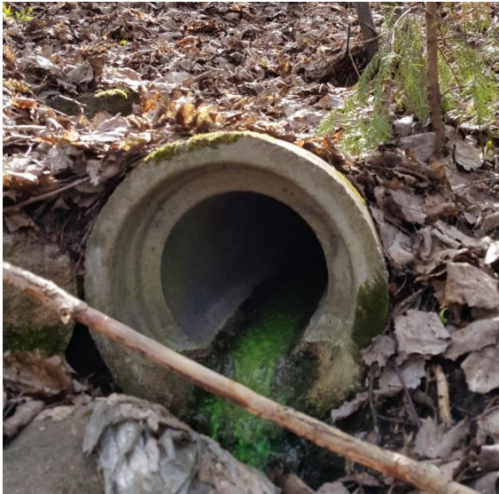
Figur 15 Dagvattenledningens utlopp i slänten norr om glasbruket.
