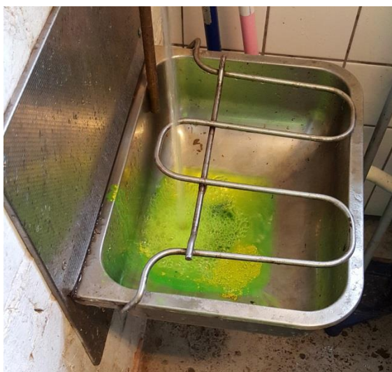
Figur 13 Grovslasken i smedjan kopplad till dagvattensystemet (dagvattenbrunn 2).
