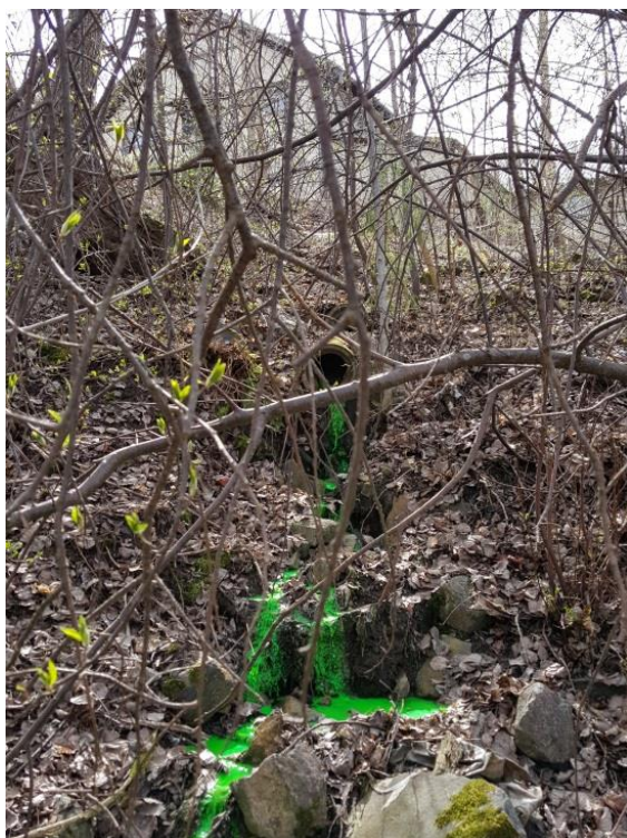
Figur 16 Dagvattenledningens utlopp i slänten norr om glasbruket.
