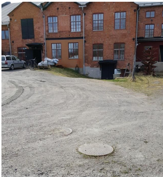
Figur 12 Dagvattenbrunn 2 och spillvattenbrunn S2.
