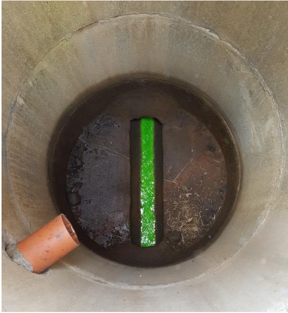
Figur 14 Dagvattenbrunn 3. Regnvatten från takrännor kommer in via plaströret.
